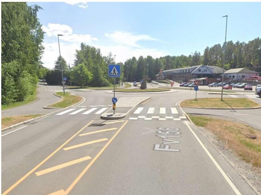
Figur 6-25: Eksisterende gangfelt ved rundkjøringen på Skoklefall. (Foto: Google street view - 2023)
