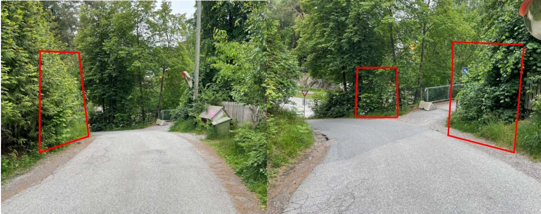
Figur 7-9: Bildene viser områder hvor det bør fjernes vegetasjon for å utbedre sikten langs Grøndahls vei og til gangbrua over fv. 156. (Foto: Multiconsult)
