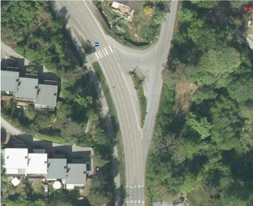
Figur 7-11: Dagens kryssutforming i krysset fv. 156 x Oksvalveien. (Flyfoto: Finn.no).
