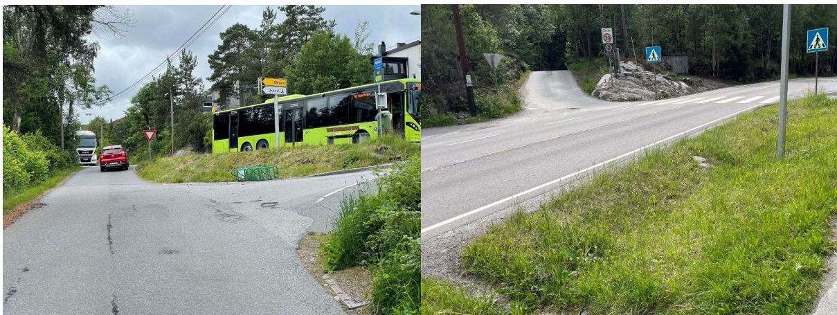
Figur 7-8: Eksisterende kyssutforming i Oksvalveien til venstre og i Dalsbergstien til høyre. (Foto: Multiconsult)
