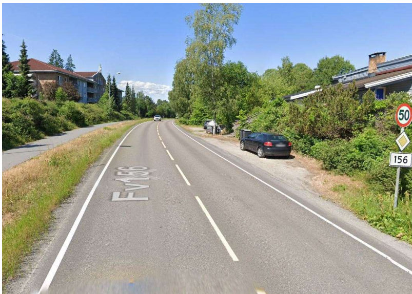
Figur 6-3: Eksisterende situasjon med avkjørsler direkte ut på fv. 156 på strekningen mellom Oksvalveien og Grøndahl vei. (Foto: Google street view)
