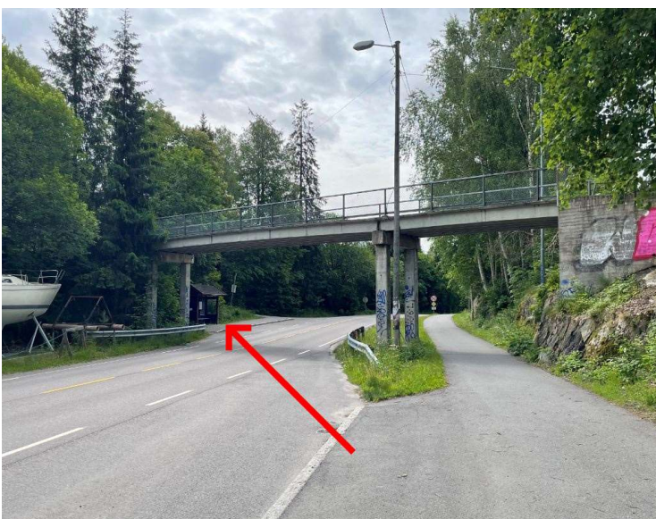
Figur 6-20: Sannsynlig trasé for fotgjengere som krysser fv. 156 i plan over til nordgående bussholdeplass. (Foto: Multiconsult)
